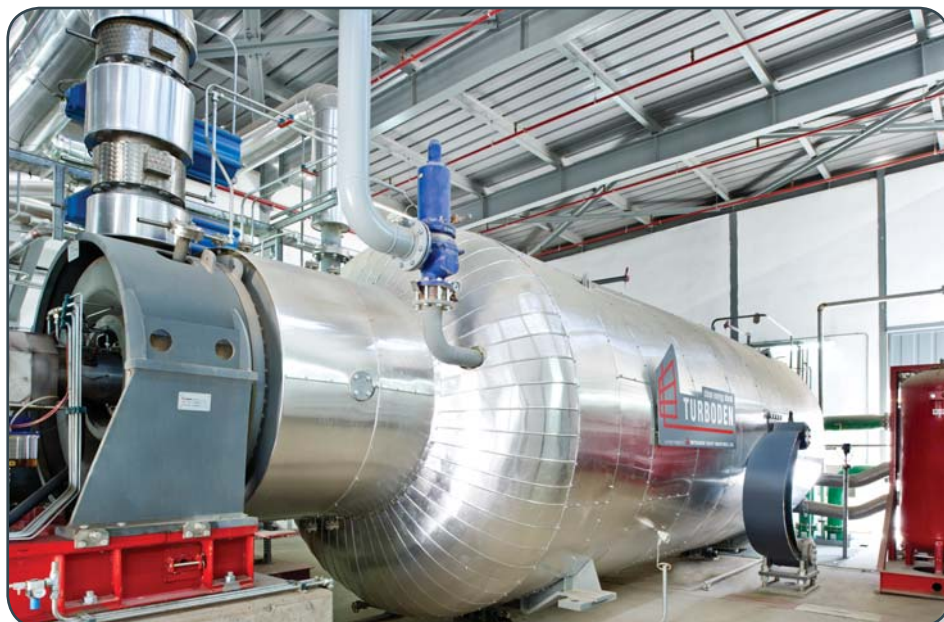
Цементный завод мощностью 2 МВт
